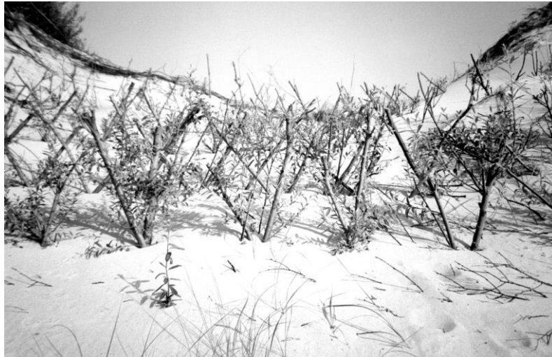
Рис. 2. Ажурная защита из ивовых кольев для восстановления разрушенных в результате абразии и дефляции участков авантюны
